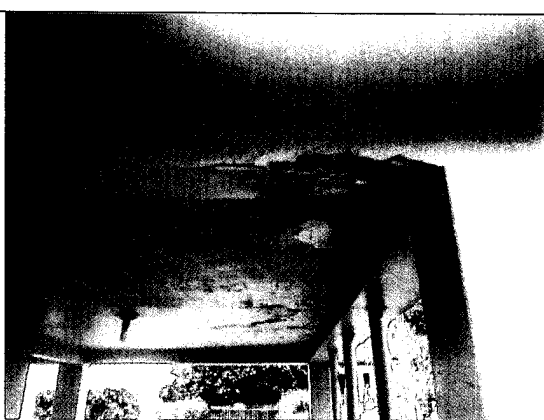
Detalhes da varanda parte da laje aparente
